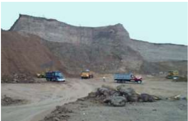
Figura 18. Banco de material San Bernardo en extracción de tepetate.
